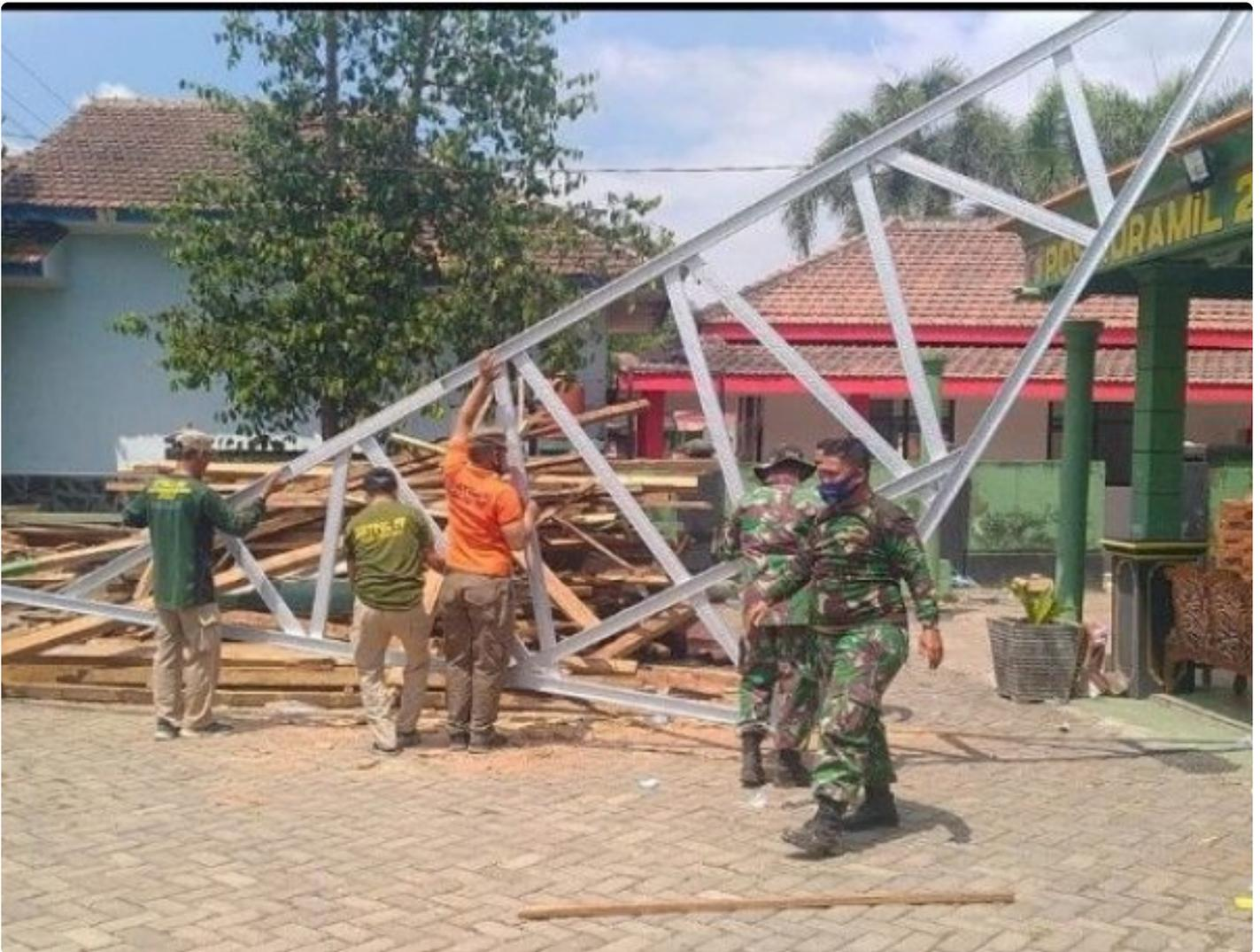
JEMBER - Setelah dilakukan pembongkaran, semua kayu kerangka atap Markas Pos Koramil 0824/29 Ajung diturunkan, kini mulai dilakukan pemasangan kerangka baru menggunakan baja ringan atau galvalum, tampak anggota semangat menaikan kerangka atap.
